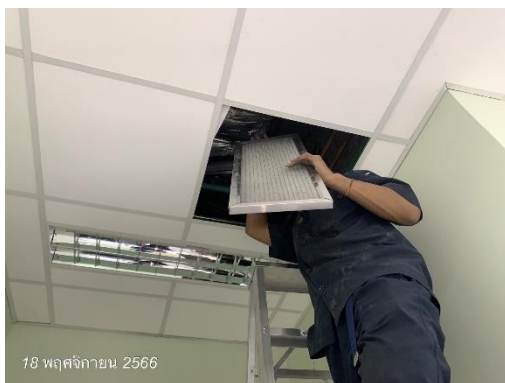
ภาพที่ 2-6 เจ้าหน้าที่ทำความสะอาดเครื่องปรับอากาศ
