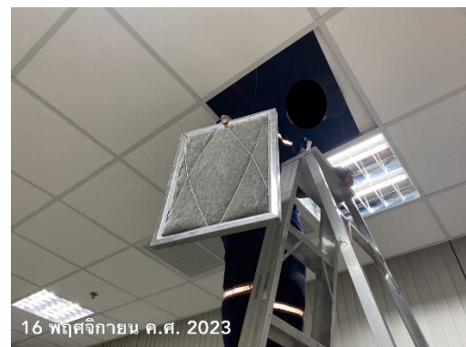
ภาพที่ 2-6 เจ้าหน้าที่ทำความสะอาดเครื่องปรับอากาศ
