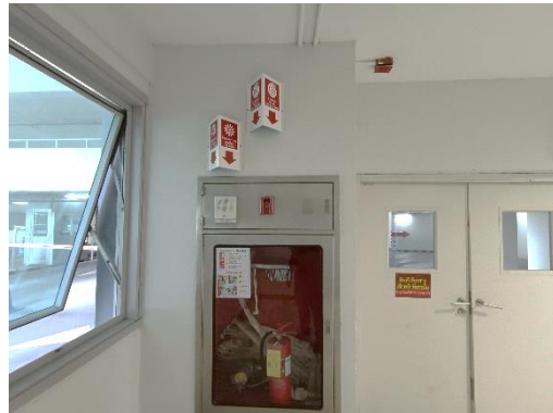
ตู้ FHC, ป้ายแสดงวิธีการใช้อุปกรณ์ดับเพลิง ไฟฉุกเฉิน กริ่งเตือนภัย ที่ตั้งรณีกเกิดเหตุเพลิงไหม้
