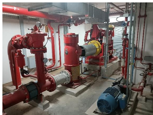
ปั๊มสูบน้ำดับเพลิง และ jockey pump อาคารพัก พยาบาลและเจ้าหน้าที่
