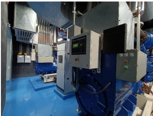
ห้องเครื่องกำเนิดไฟฟ้าสำรองมีการบุด้วยวัสดุดูดซับ
